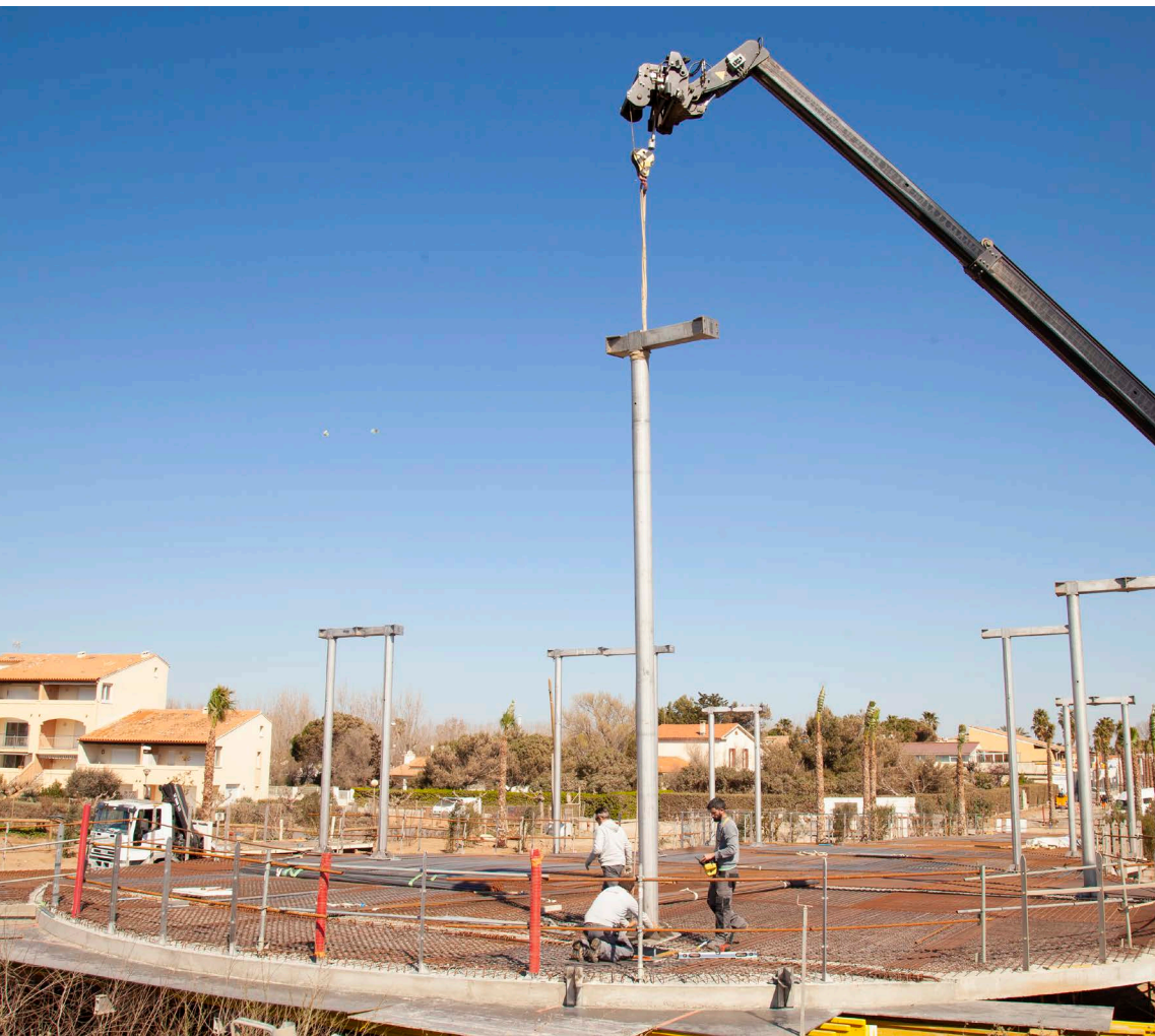
Construction de la montée sur la mer et installation des pergolas
