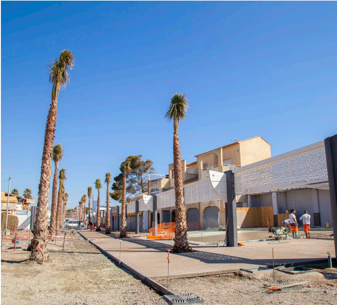
Plantation des palmiers, mise en place de la devanture des commerces, et coulage des bétons
