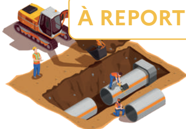
Travaux en cours d'eau
