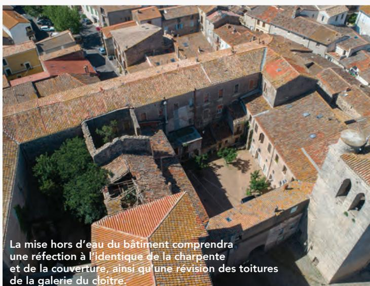
La mise hors d'eau du bâtiment comprendra une réfection à l'identique de la charpente et de la couverture, ainsi qu'une révision des toitures de la galerie du cloître.
