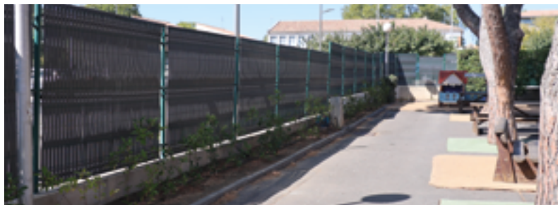
Pose de brise-vues occultants
