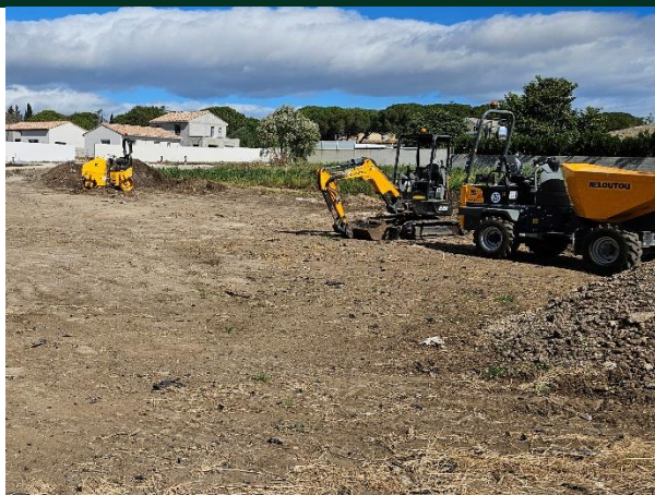
Zone de sol nu servant au stockage de matériel BTP
