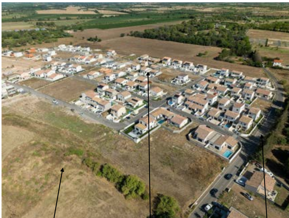
Villas des tranches 1 et 2
