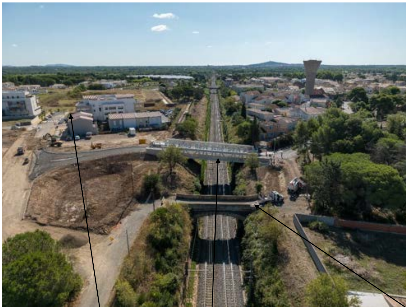
Nouveau pont route
