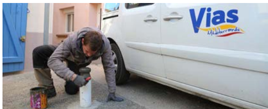
Petits travaux effectués par les services techniques (Bornes de stationnement)
