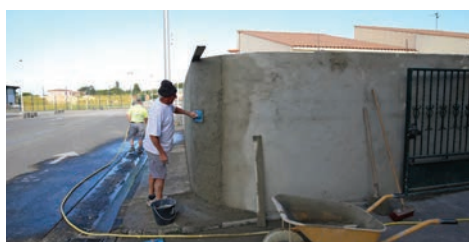
Divers travaux ont été effectués pour rénover les locaux
