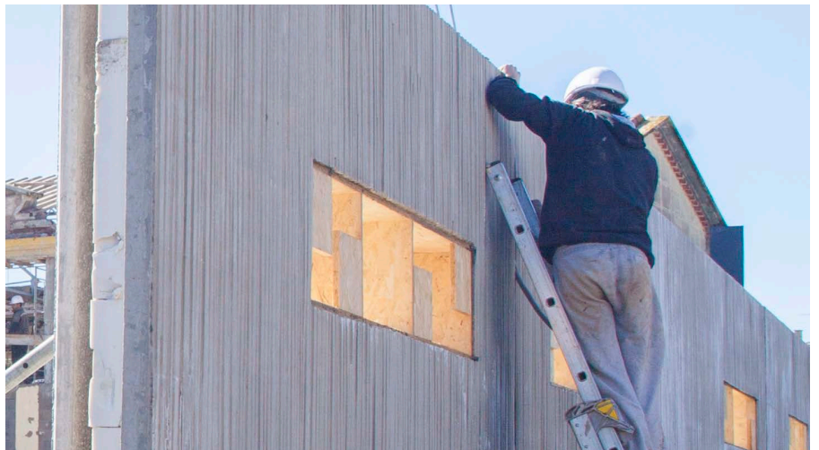
Pose des murs moulés en imitation bambou
