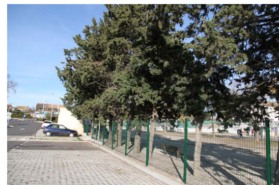
• Pose d'un grillage aux abords du boulodrome - Novembre 2018
