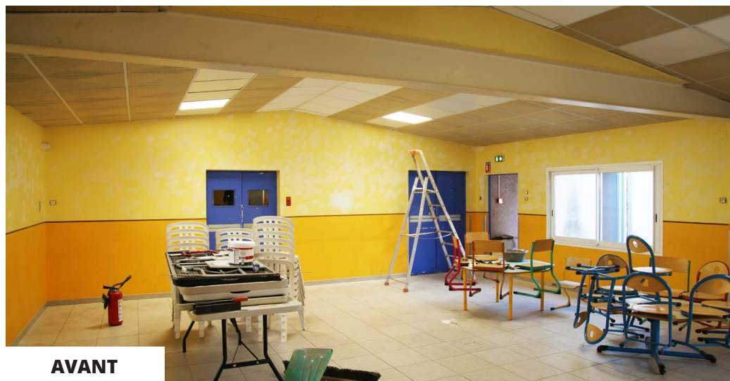
• Réfection totale de la grande salle du centre aéré du Libron – Octobre 2018
