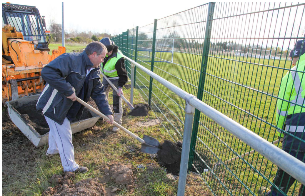
• Remplacement du grillage au stade Gaby Castell – Novembre/Décembre 2018
