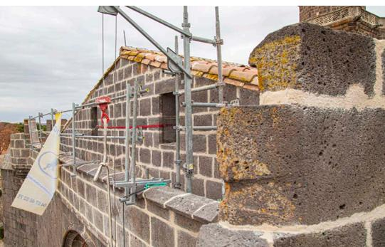
*Purge des joints en ciment et reprise au mortier de chaux sur le chemin de ronde et ses abords.*
