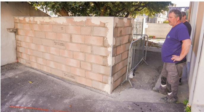
Construction du mur du local poubelle de la crèche avec au sol une dalle de béton
